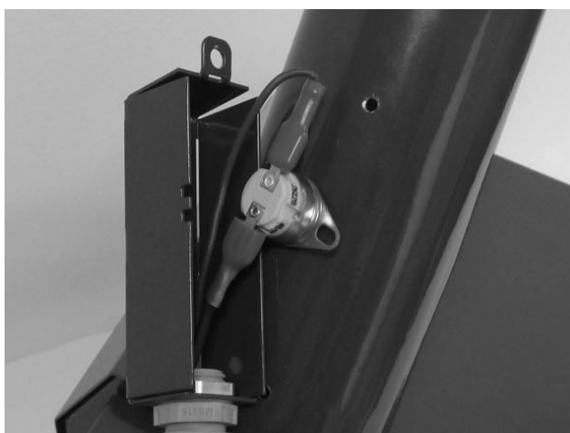
Fig. 10 – termostat de siguranță 95°C pe conducta de aducere peleti
