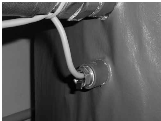
Fig. 13 – imaginea senzorului de temperatură apă în teaca rezervorului de acumulare (TV și TS)
