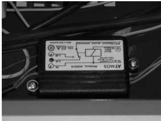
Fig. 11– modul AD04 pentru funcțiile speciale ale arzătorului
