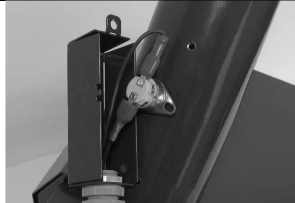
Fig. 10 – termostat de siguranță 95°C pe conducta de alimentare cu peleți
